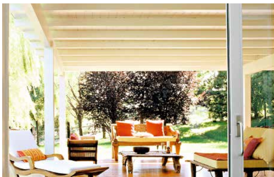
Casa de bajo consumo energético Colombia, Italia – construida por Rubner Haus AG
