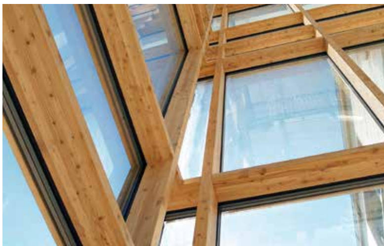
Fachada de cristal con cerramientos de madera, Sede de Züblin Z3, Stuttgart, Alemania
